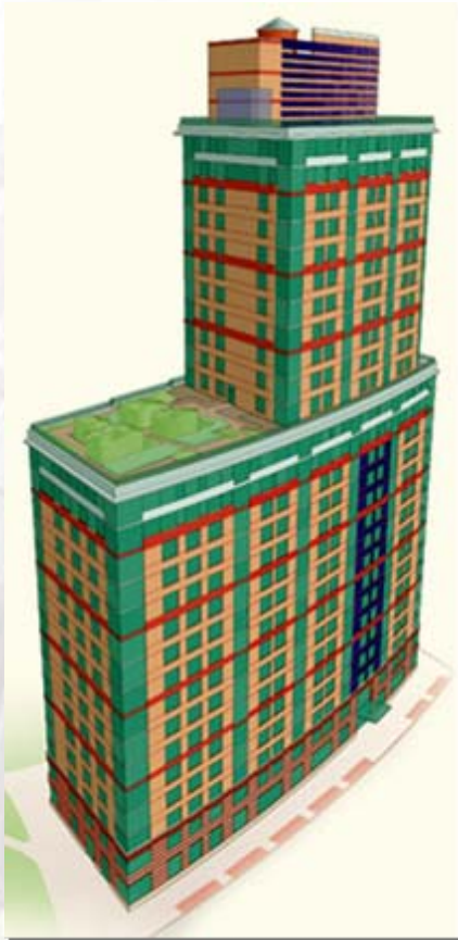
The Solaire, New York
